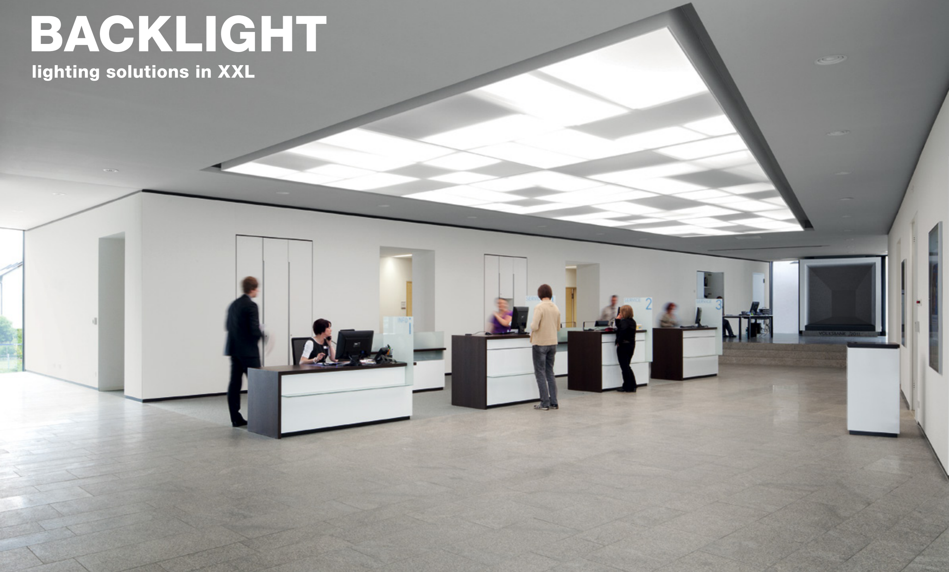
Spanndecke aus Lichtelementen; Backlight tex in Freiform, eingefügt in Deckenaussparung.
