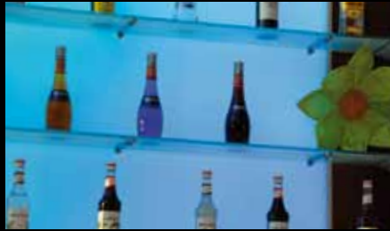
Thekenrückwand aus Lightpanel mit RGB-LEDs. Für die Glasträger wurde das Lightpanel durchbohrt.
